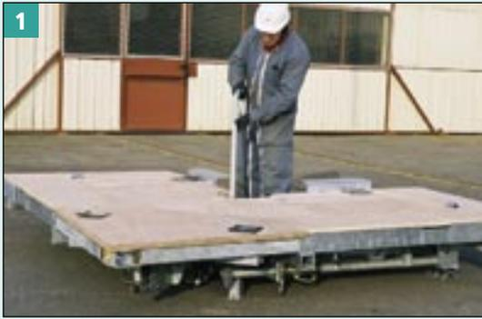
1 Mettre en place la crosse d'accès orientée côté échelle.
